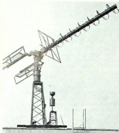
Bild 2. Antennensystem einer Wettersatelliten-Empfangsanlage. Im Hintergrund Funkbeschickungsantenne. Standort: Zentralamt des Deutschen Wetterdienstes, Offenbach am Main
